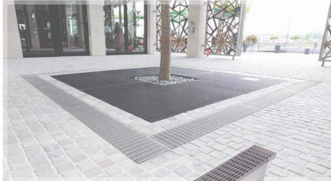
Um die optische Wirkung der Edelstahl-Maschenroste auch im Zentrum aufzugreifen, umsäumen Rinnen des Typs Cubo eine für den Baum angelegte Sickerfläche. Diese ist mit schwarz beschichteten, rutschhemmenden Maschenrosten abgedeckt und bildet einen reizvollen Kontrast zu der glänzenden Metallstruktur der Dränagesysteme.
