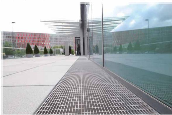
Die sonderangefertigten Entwässerungsrinnen mit Einlaufbreiten von bis zu 50 Zentimetern gewährleisten eine optimale Abführung des anfallenden Fassadenwassers.
