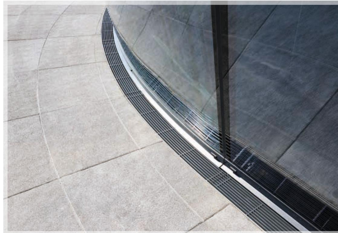
Die Geradlinigkeit der nach Südwesten ausgerichteten Fassadenfront der Halle 3C mündet in einen großen Bogen, in dessen Verlauf sich der südöstliche Fassadenabschnitt auch noch nach vorne neigt. Dem Verlauf der Fassade folgend schmiegt sich das Rinnensystem passgenau an.
