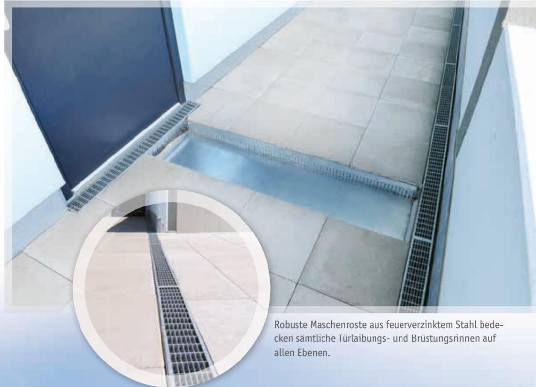
Robuste Maschenroste aus feuerverzinktem Stahl bedecken sämtliche Türablaufs- und Brüstungsrinnen auf allen Ebenen.
