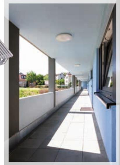
Entwässerungsrinnen entlang der Brüstungen der mediterran wirkenden Laubengänge nehmen Niederschlagswasser der Fläche sowie der Türabläufe ab. Beide Anwendungsbereiche der Rinnen sind über Revisionskanäle miteinander verbunden.
