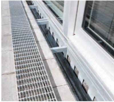
Durch die Drainage-Lochreihen am Boden des Kanals sowie über die feuerverzinkten Maschenroste werden die anfallenden Niederschlagswasser aufgenommen und über die Ablaufstutzen der Rinnen abgeführt.
