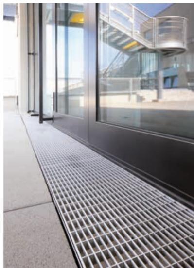
langlebig stand. Mittels Verriegelungen sind die Roste der Richard Brink GmbH & Co. KG zusätzlich fest verankert. Rinnen und Roste wurden sowohl in Standardausführung als auch in projektspezifischen Sondermaßen geliefert. Mit verschiedenen Längen von 600 bis 2.600 Millimetern fügen sich die Drainage-Elemente in die Außenflächen ein und passen sich den Fensterlaibungen an.
