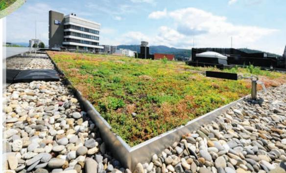
Für die Sedum-Dachbegrünungen produzierte das Unternehmen Richard Brink 882 m Substratschienen aus Aluminium. Diese separieren die Bepflanzungen von den vorgeschriebenen Kiesstreifen der Dachränder. Mit ihren 160 mm Höhe geben diese dem Pflanzsubstrat samt Sedum-Bepflanzung ausreichend Aufbauhöhe. Darüber hinaus unterteilen sie mehrere Dachebenen, die mit Splittbetten bedeckt wurden, und geben den Natursteinen den nötigen Halt.
