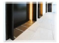
Rinnen und Roste wurden in den Einlaufbreiten zwischen 100 und 258 mm sowie in den jeweils gewünschten Längen auf Maß gefertigt. Laibungstiefen und -längen wurden somit passgenau ausgefüllt, ohne dass Zuschnitte erforderlich waren.
