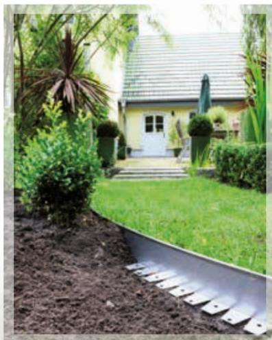
Nach dem Ausrichten werden die Beeteinfassungen mittels Stahlstiften, die durch die Ausstanzungen in den Auflageflächen genagelt werden, im Boden fixiert. Die Auflageflächen dienen jedoch nicht nur der Fixierung, sondern verhindern später auch das Einsinken ins Erdreich. Die Druckbelastung durch Personen oder Maschinen wird durch die Auflageflächen abgefangen.
