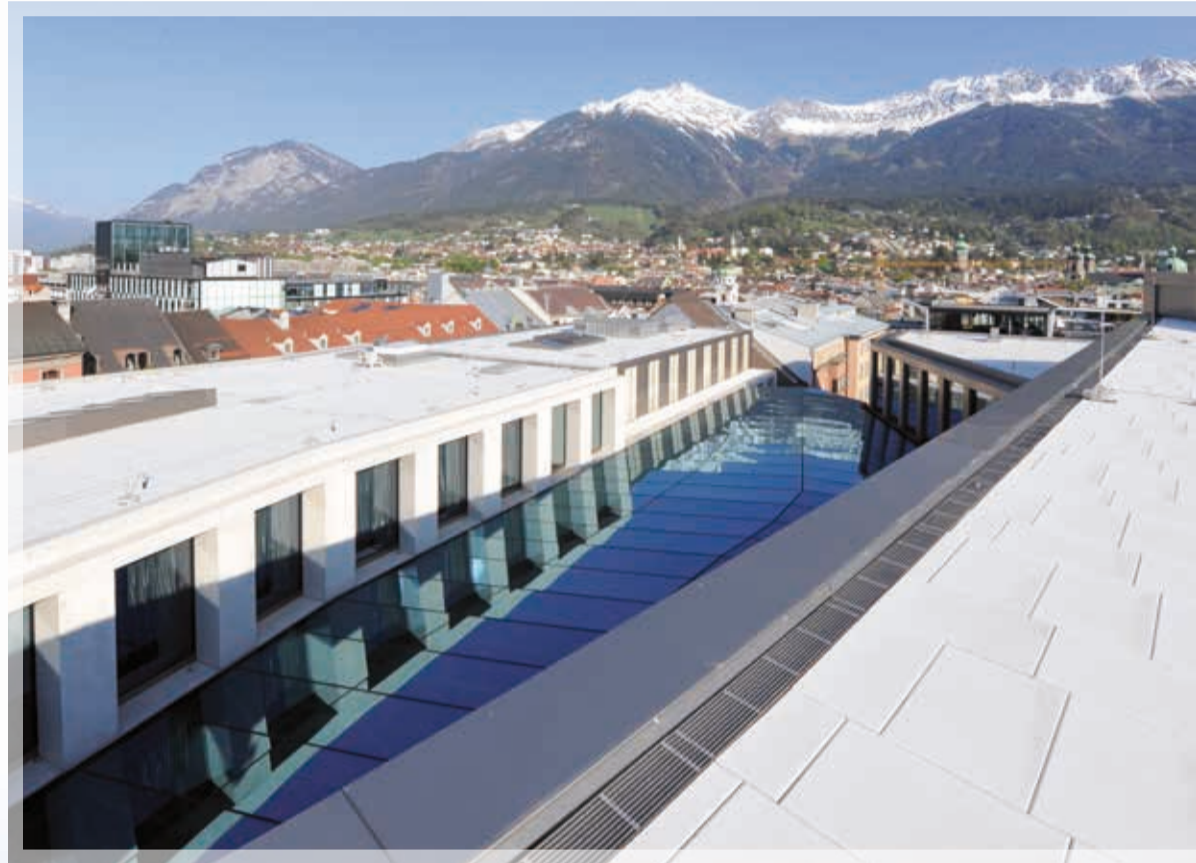
Maßgefertigte Edelstahl-Dränagerinnen mit 20x3 mm Längsstabrost umschließen die Dachflächen des Kaufhauses Tyrol.
