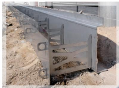
Die neue Rigolenrinne Rigoletto ist eine breit angelegte Dränagerinne ohne Boden. Dank der Materialstärke von 4 mm, den Verbindungsstreben sowie den in Beton eingefassten Ankerlaschen widersteht diese Versickerungsrinne einer Radlast von bis zu 5 Tonnen.
