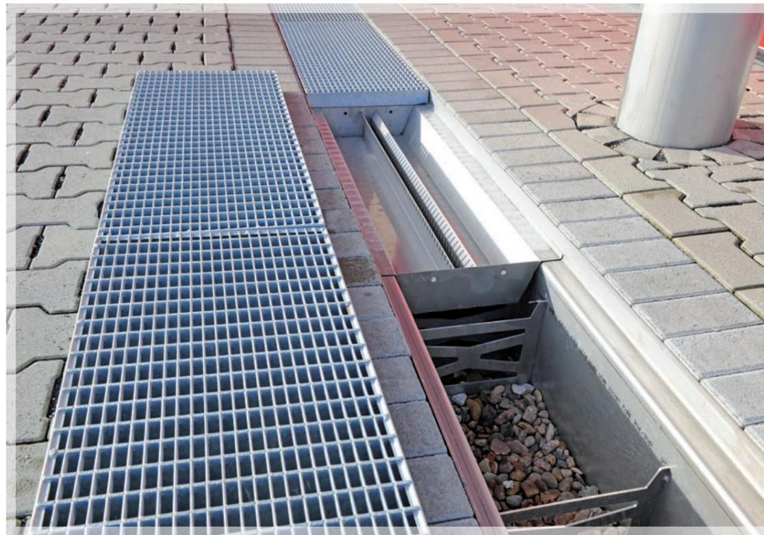
Diese Abbildung zeigt die Rigolenrinne im fertiggestellten Einbau. Die eingehängten Schmutzfangwannen bewahren die zuvor eingefüllte Drainage-Kiesschüttung vor Verunreinigungen durch Laub, Müll und Sand.
