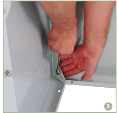
Eine zusätzliche Schraubverbindung wird direkt unten am Fuß des Pflanzkastens angebracht. 3
