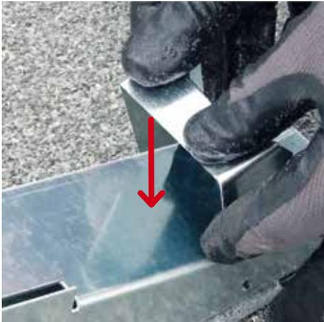
Haken aufsetzen und senkrecht in die Schlitz im Ständerelement stecken. Dabei darauf achten, dass der Haken nicht zwischen Ständerelement und Unterteil steckt, sondern ganz innen sitzt.
