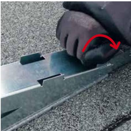
Haken mit etwas Kraft nach hinten kippen (wenn der Haken klemmen sollte, einen Schon- oder Gummihammer verwenden und den Haken in die passende Position bringen).
