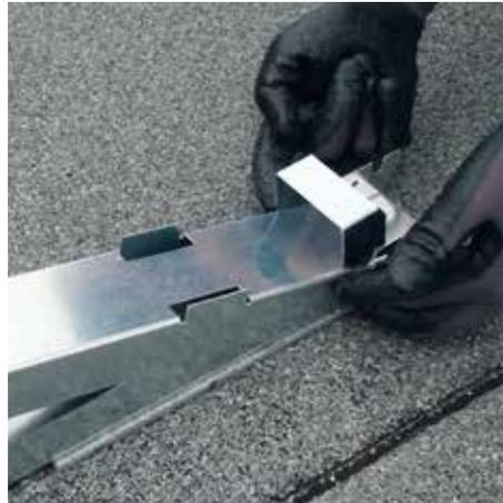
Die beiden Nuten vorn im Haken müssen in das Ständerelement greifen.
