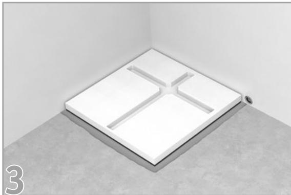
**3** Unteren XPS-Block mit wandseitigem Schallschutzband zur Verrohrung aufsetzen
