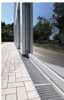
RichardBrink\_HomebBerlin\_06 Un total de 141 m de caniveau en acier galvanisé entoure chaque bâtiment au niveau de ses soubassements. En plus de différents formats standard, Richard Brink propose aussi des modèles sur mesure avec saillie supplémentaire pour embrasure, ainsi que des grilles assorties pour une finition toujours professionnelle et esthétique.
