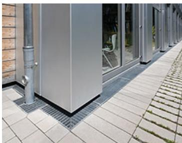
RichardBrink\_HomebBerlin\_04 En plus des caniveaux en tant que tels, le fabricant allemand fournit également des angles rentrants, des angles sortants, des bouches d'évacuation et des caillebotis assortis avec découpe pour tuyau de descente.
