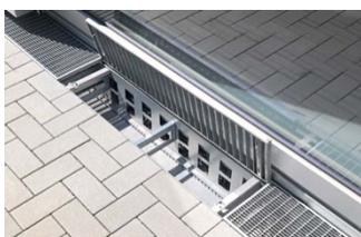
RichardBrink\_HomebBerlin\_05 « Stable Air » est doté de larges ouvertures de ventilation qui assurent une aération continue des soubassements. Il empêche aussi les remontées d'eau par capillarité grâce à son éloignement de la façade. Le bois reste ainsi durablement protégé de l'humidité.
