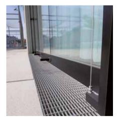
Entwässerung. Insgesamt wurden ca. 255 Meter an Rinnen und Rosten verlegt. Das robuste Material der Produkte hält der starken Frequentierung dauerhaft stand.
