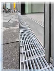
Die Rinnen haben eine Einlaufbreite von 153 mm mit der Nennweite DN 100 bzw. 203 mm und DN 150. Der Metallwarenhersteller hat die Länge der Rinnen und Roste in Sondermaßen angefertigt, damit sie sich harmonisch in die Türlaibungen einfügen. Da die Verarbeiter der Gzimi – Garten- und Landschaftsbau GmbH diese Bauteile auf der Baustelle nicht mehr zuschneiden mussten, sparten sie wertvolle Zeit beim Einbau.
