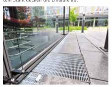
Vor den Eingängen stellen zudem parallel verlaufende Schlitzrinnen des Typs Lamina eine ausreichende Entwässerung sicher. Insgesamt wurden 107 lfm dieser Rinnen verlegt. Sie haben eine Gesamthöhe von 260 mm und eine Halshöhe von 160 mm. Angeschlossene Revisions- und Spülkästen dienen der optimalen Säuberung der Rinnen.
