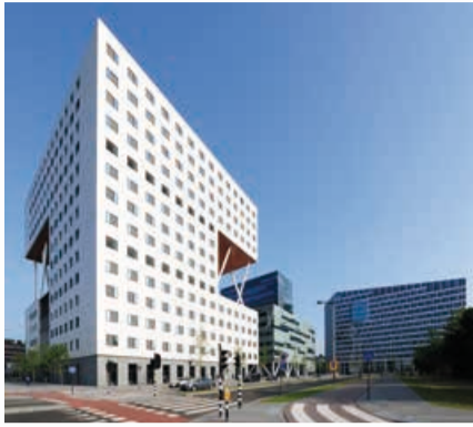
Effizientes Labor: „0|2“ der VU Amsterdam
